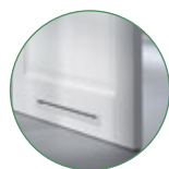
Respiradouros de passagem
